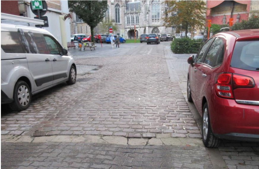
De Kerkstraat is aangelegd in klinkers en plots op het kruispunt met de Sint Paulusstraat in Kasseien.
